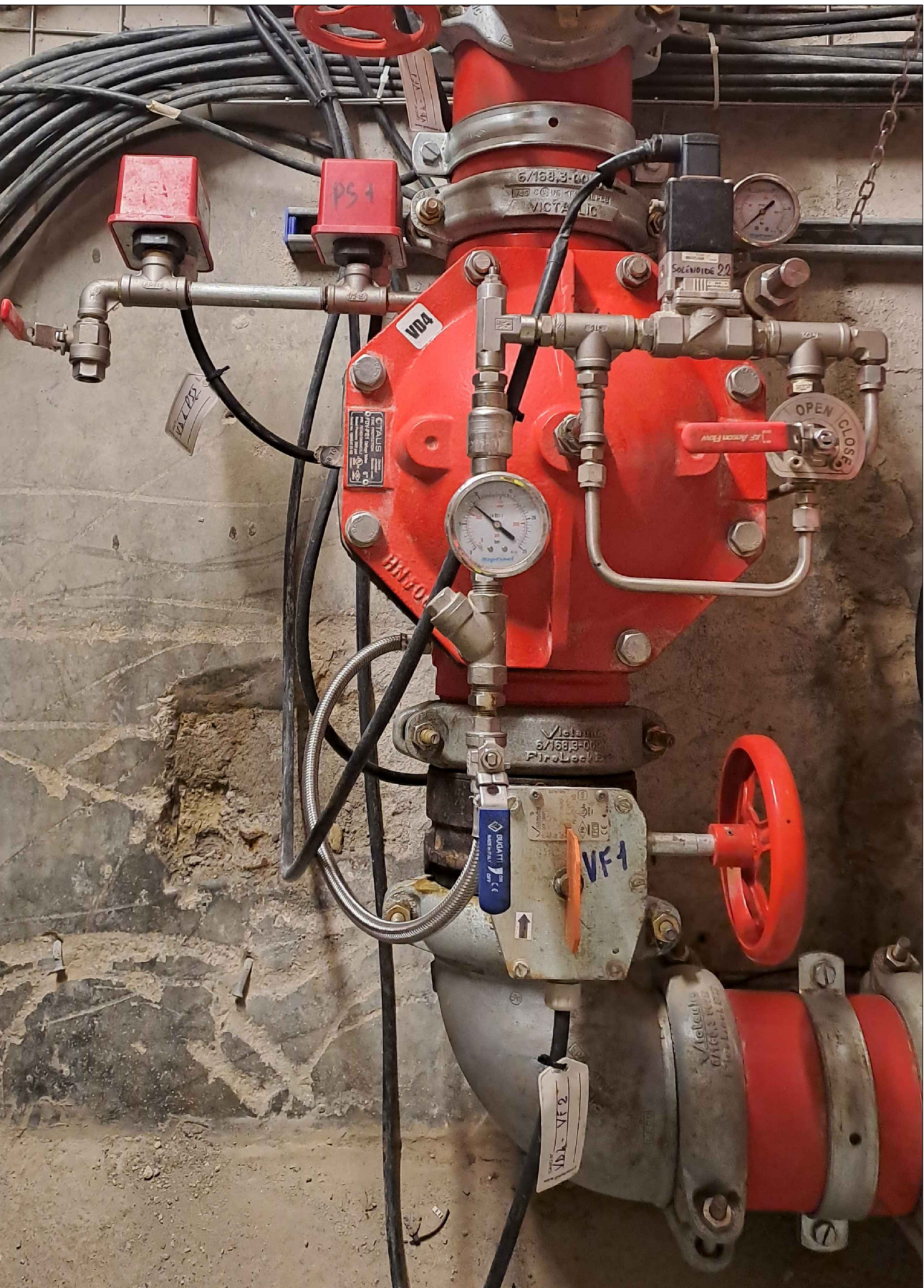
DETTAGLIO VALVOLA A DILUVIO RAPHAEL IM-FT 245-11-C-G DN150 (FIRING FDV-PE1 DN150)
