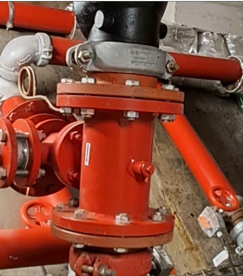
DETTAGLIO MISCELATORE SCHIUMOGENO SDM URD 0125 (FIRING URD 0125)
